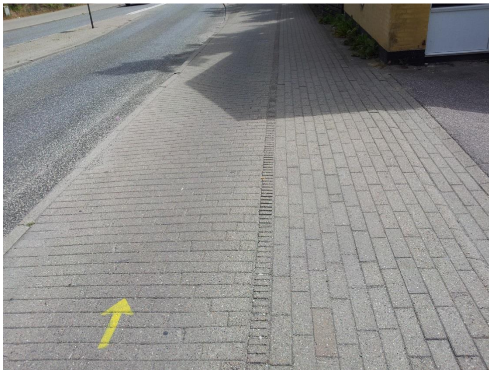
Figur 8 Belægning på de delte stier langs Kollerødvej.
